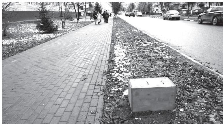
Ноябрь 2024 г. Законсервированные наружные выходы электросети после демонтажа светильников
