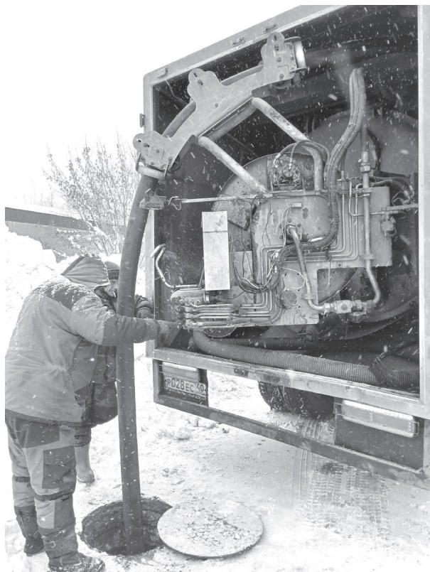
Бригада Водоканала прочистила канализационные сети и колодцы на Дзержинского
