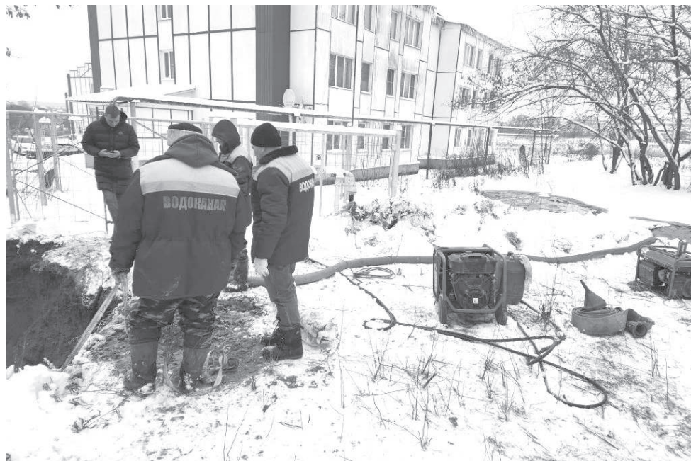
Аварийная бригада устраняла протечку в сети ХВС, снабжающей малоэтажные дома на улице Лесной
