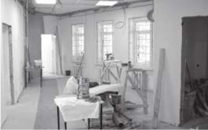
Ремонт продвигается ударными темпами
