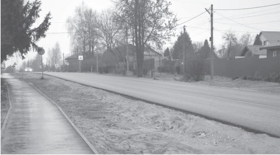
Дороги и тротуары обновлены
