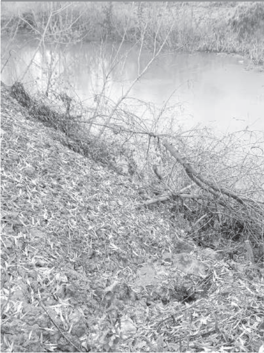
Канализационные стоки, разливающиеся по улице, попадают аккунрат в местный пруд
