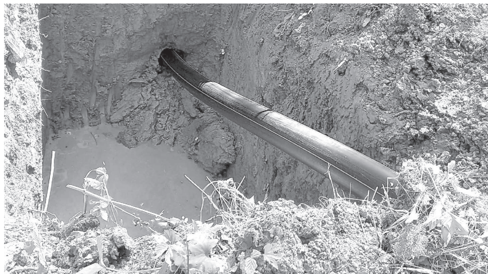
На улице Дзержинского продолжают работы по присоединению домов к новому трубопроводу ХВС
