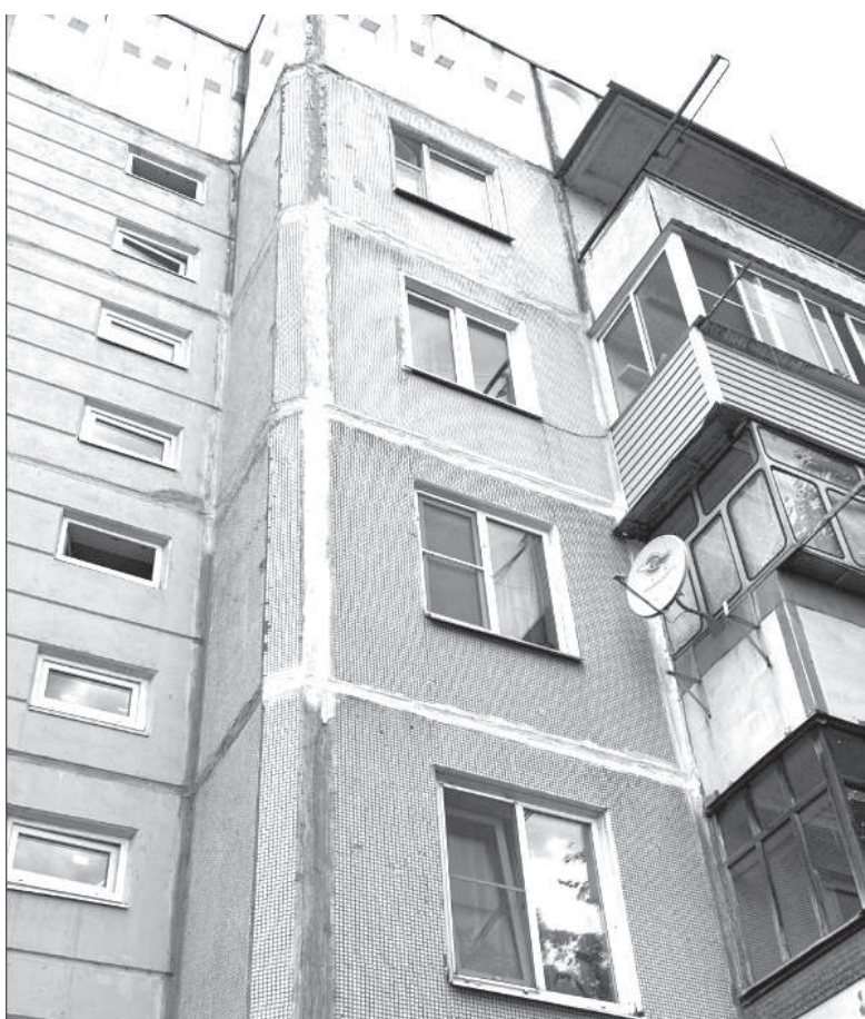
Герметизация межпанельных швов устраняет теплопотери
