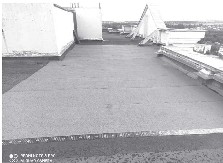
Локальный ремонт кровли дома 22 по улице Гагарина
