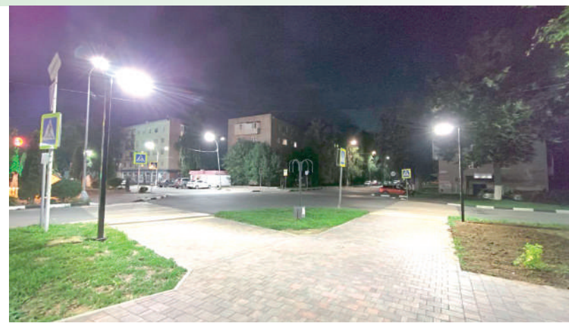
В рамках устройства тротуара на ул.1 Мая было установлено дополнительное освещение пешеходных переходов
