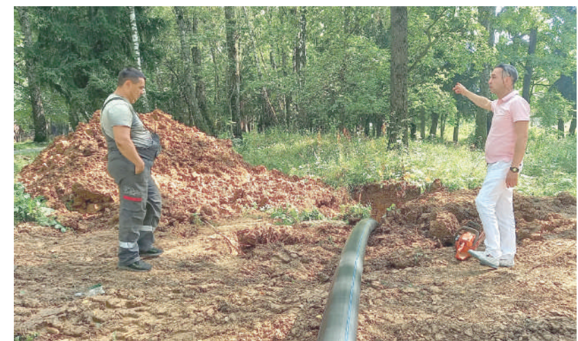
Глава города Руслан Жадьков проверяет работы по прокладке нового трубопровода от первого городка к третьему
