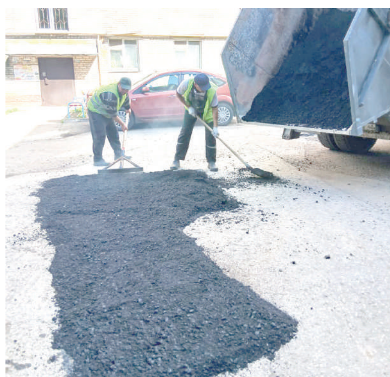
...и укладка асфальта
