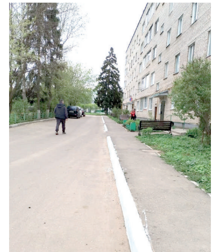
Фасады старых пятиэтажек утепляют поэтапно
