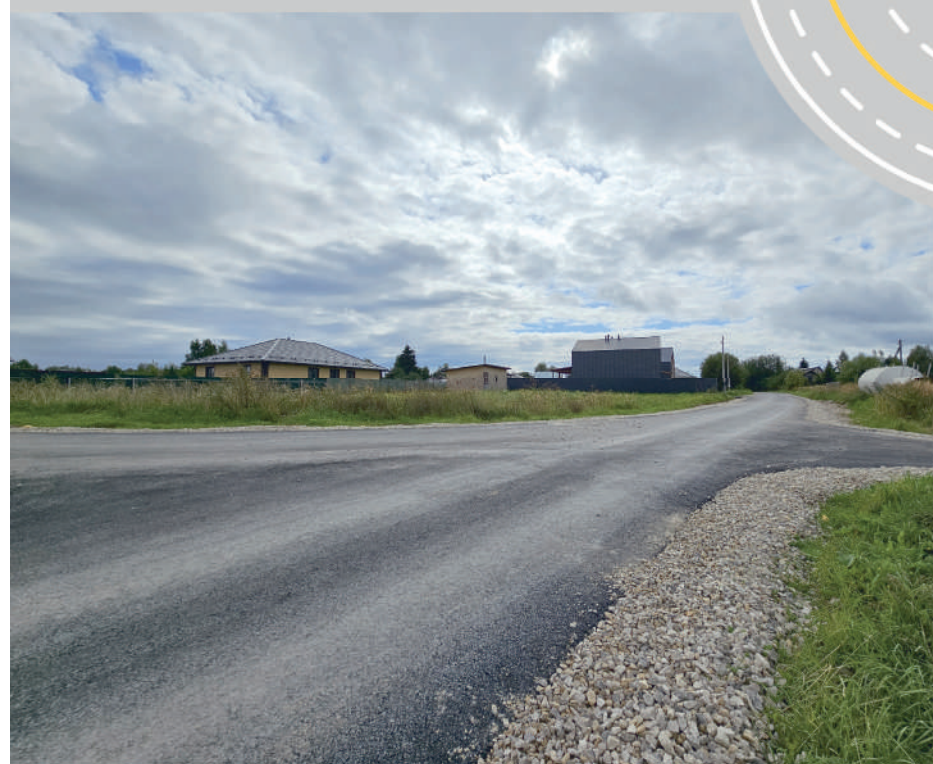
В Комлеве закатали в асфальт съезд с Центральной и все примыкающие улицы в сторону Солнечной
