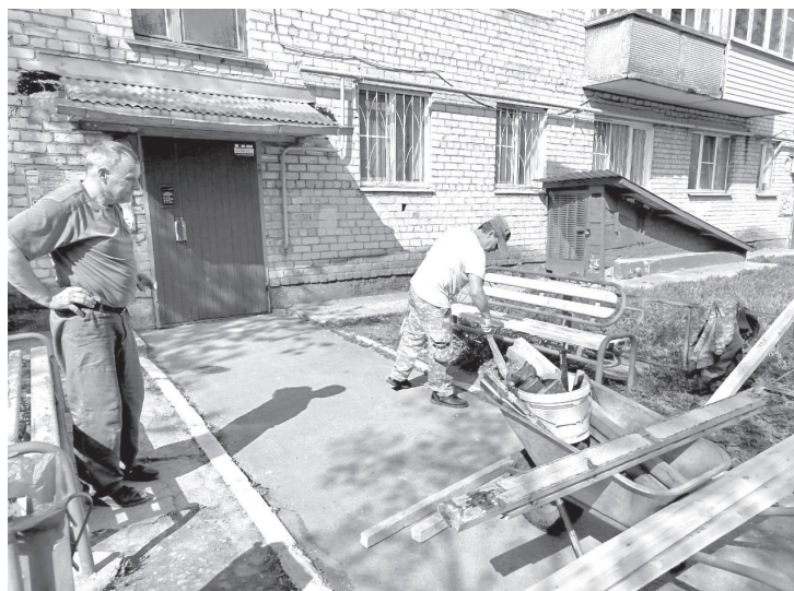
По обращениям жильцов идёт ремонт лавочек
