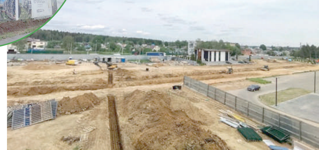
Очередной этап строительства новой дороги
