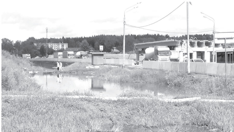
Перелив стоков после обильных дождей
