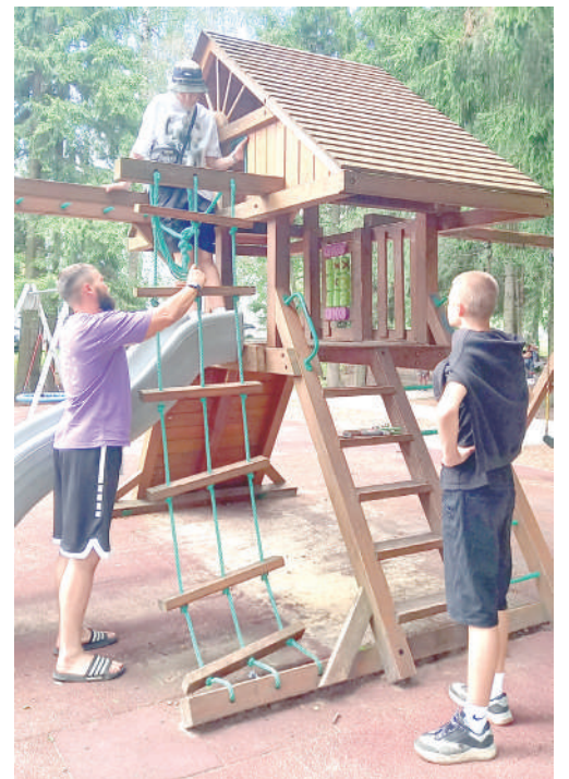
Дмитрий Чернов и подростки отремонтировали элементы детской площадки
