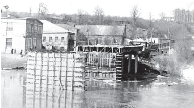
Строительство моста у фабрики 1962-1965 год. Сооружение возводила бригада, которая осталась впоследствии в Ермолино. Для рабочих специально поставили новые дома на улице Садовой
