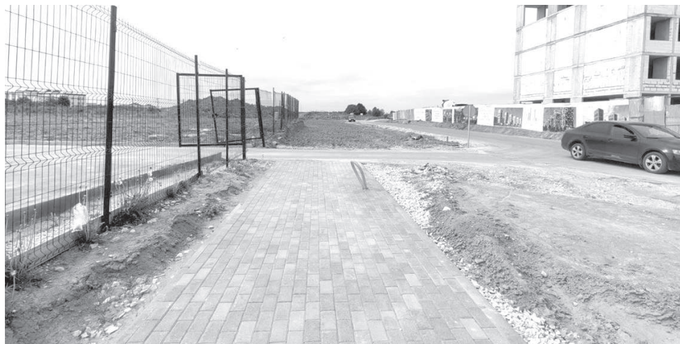
Тротуар между территорией ледовой арены и стройплощадкой ЖК «Петровский авеню» в этом сезоне значительно увеличится по протяжённости. Также здесь появятся фонари – линия электроснабжения уже проложена
