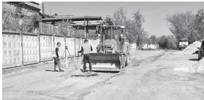
К середине июня работы по строительству парковки планируют завершить
