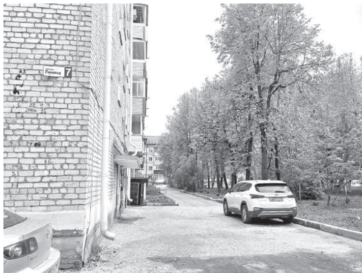
Завершаются подготовительные работы на придомовках по адресам пл. Ленина, 7 и Фабричная, 2. Вскоре там уложат асфальт
