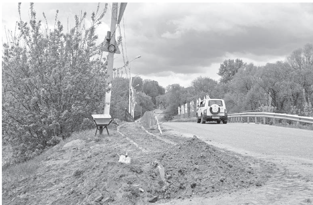
Кипят работы по благоустройству тротуара, ведущего от техникума до моста
