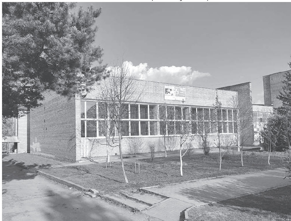
Масштабный ремонт спортшколы на Ленина в Боровске завершат к новому тренировочному сезону
