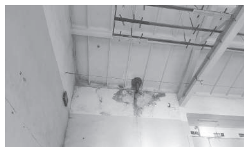
В главном зале освежат стены и потолок, к системе водостоков, проходящих внутри здания, подведут подогрев
