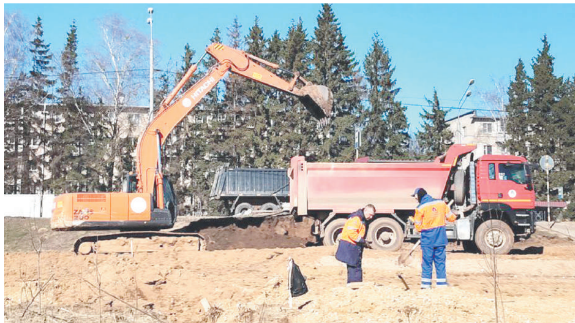
Укладка оснований для новых полос федеральной трассы
