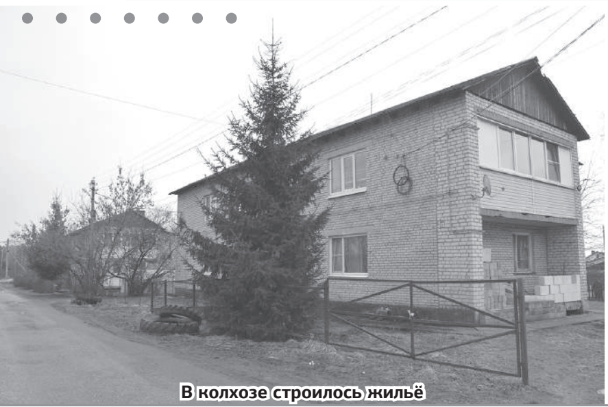
В колхозе строилось жильё
