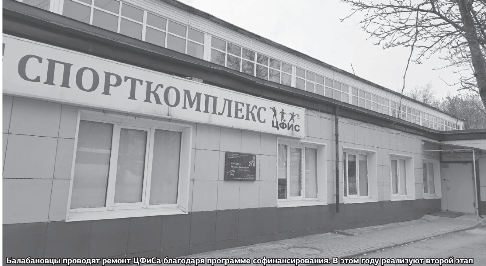
Балабановцы проводят ремонт ЦФиСа благодаря программе софинансирования. В этом году реализуют второй этап
