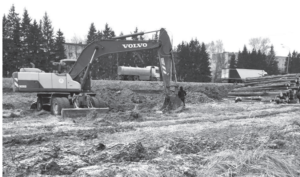
Работы по реконструкции трассы М-3 «Украина»
