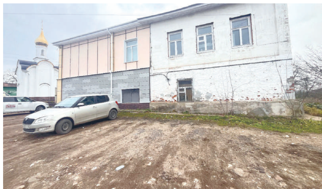
В семейном клубе «Берега» часто проходят мероприятия для детей, ждать их начала лучше на благоустроенной площадке
