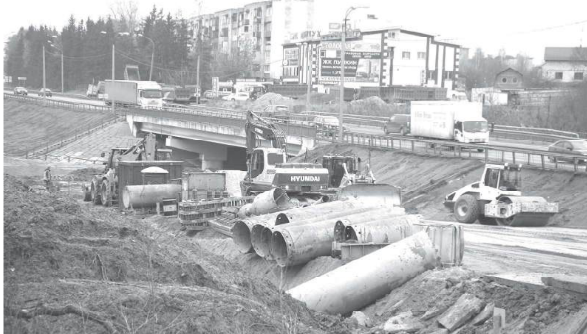
Мост через Истью. Работа кипит
