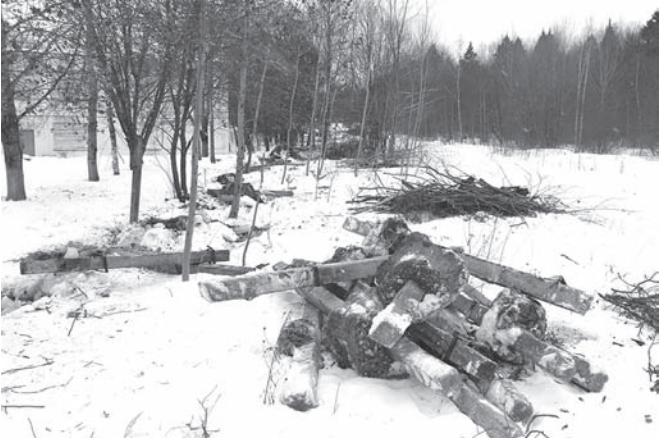
Возле очистных демонтируют ограждение
