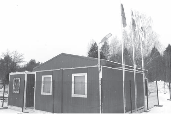
Рабочие установили бытовки
