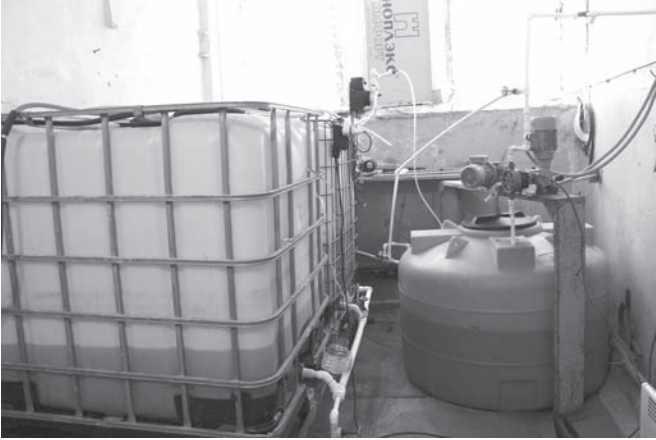
Система хлорирования воды на «Кочетовке» продумана до мелочей
