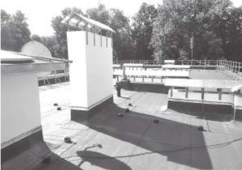
В этом году в домах ремонтируют только кровли
