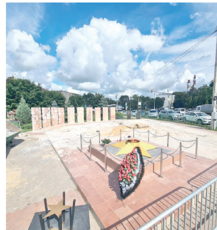
В процессе реконструкции
