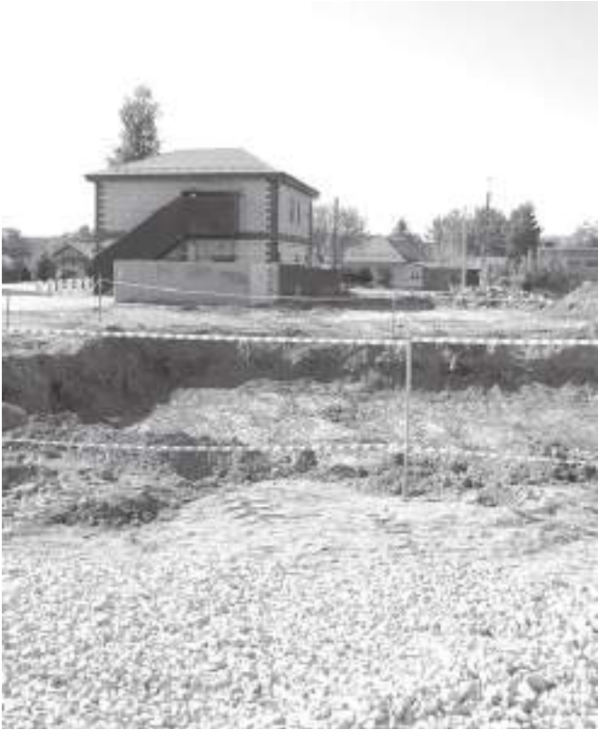
Стартовало строительство будущего медицинского центра
