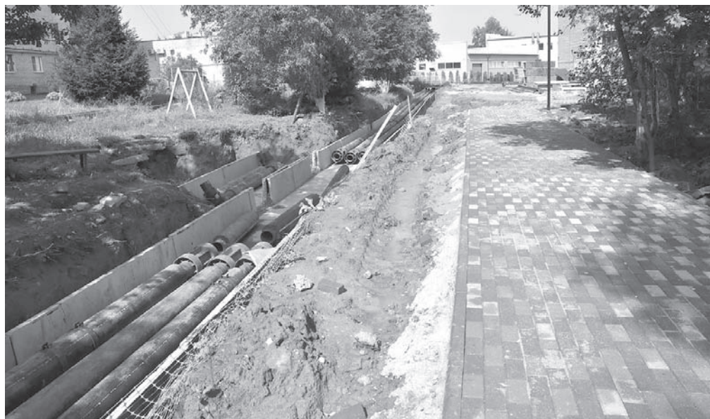
В Балабанове ещё один участок теплотрассы убрали под землю
