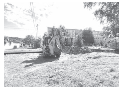
Ермолино стал единственным муниципалитетом, участвовавшим в областной программе, позволяющей проводить масштабный ремонт теплотрасс
