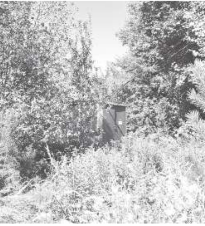
382 тысячи рублей потратили на прокладку новых линий для электропитания насосной станции. 40 процентов суммы оплатили жители, 60 – город
