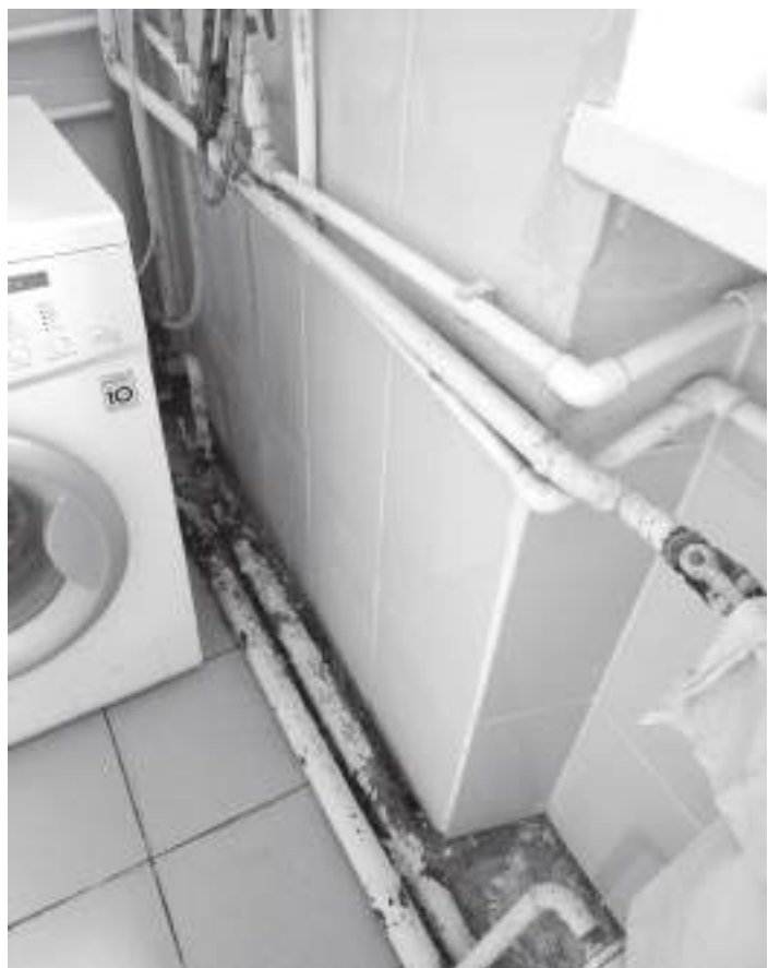
Отыгран контракт на ремонт труб холодного водоснабжения
