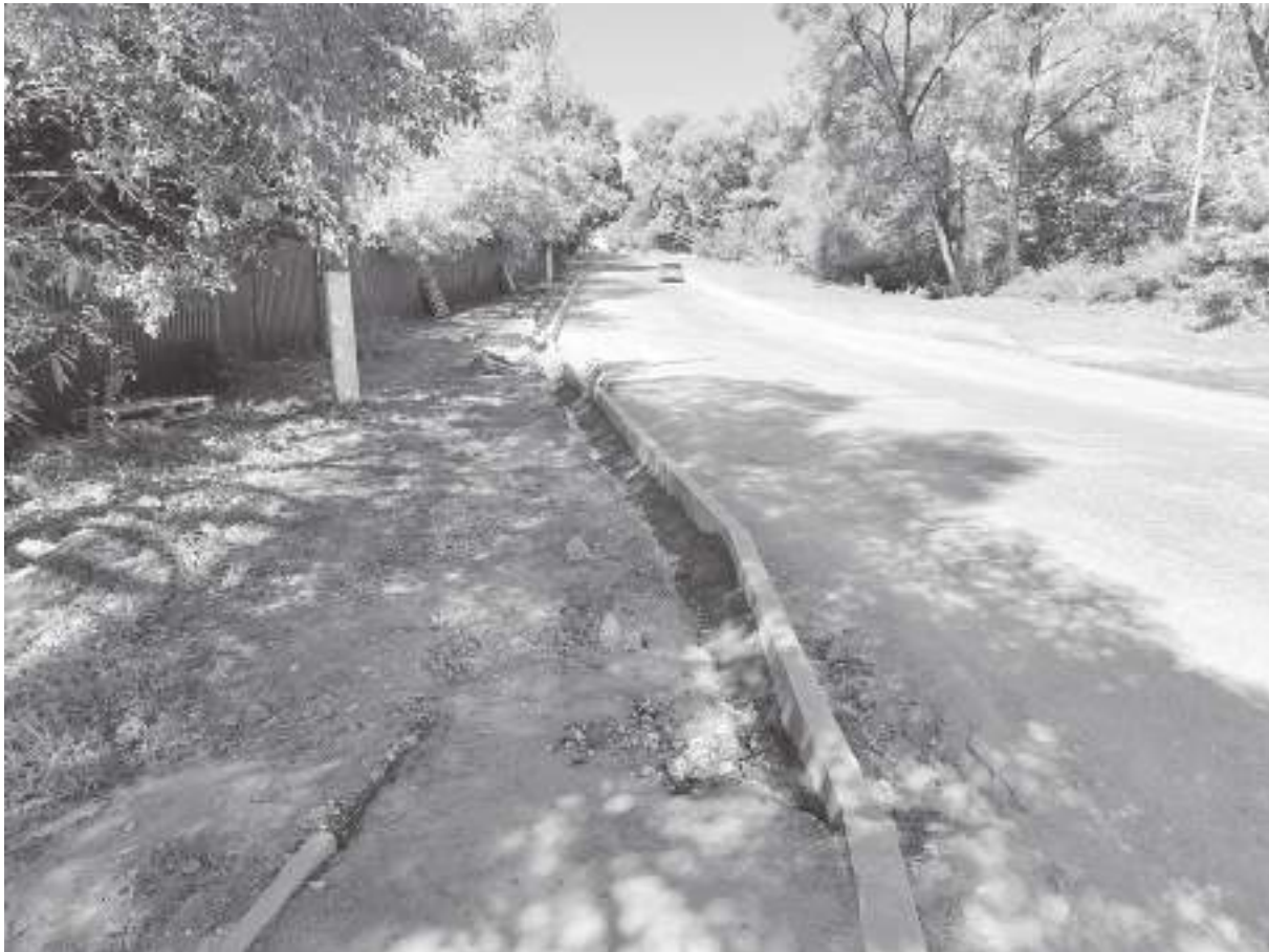
После установки бордюрного камня подрядчик займётся планированием тротуара на подъёме в горку
