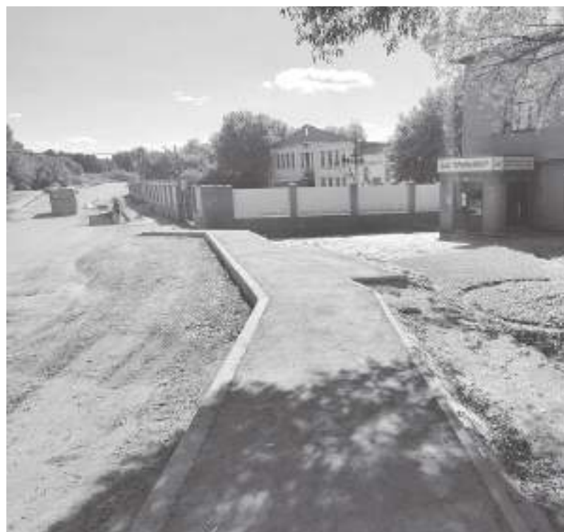
Место для автобусного павильона уже готово
