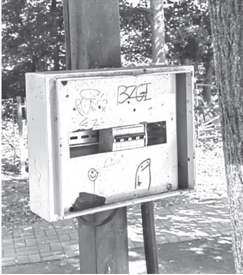
Ящик с электроавтоматами доступен для всех шаловливых ручинок
