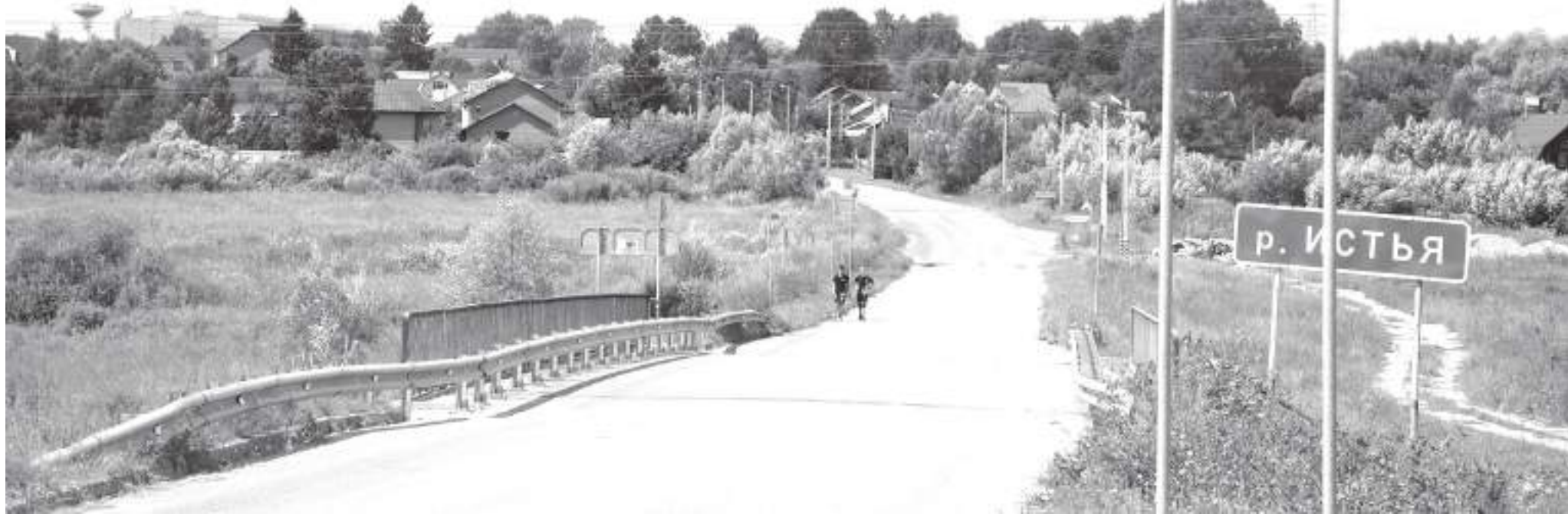
Мост через Истья
