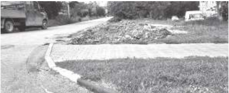
На улице Новой готовят основание для будущей дорожки
