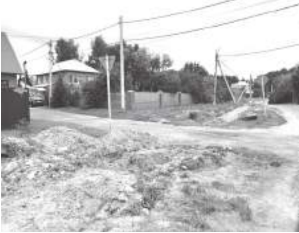
На улице Южной готовят основание для нового тротуара
