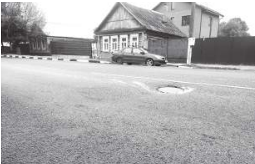
В этом месте провалился не только люк, но и подходящий к нему трубопровод, образовав на асфальте характерную волну
