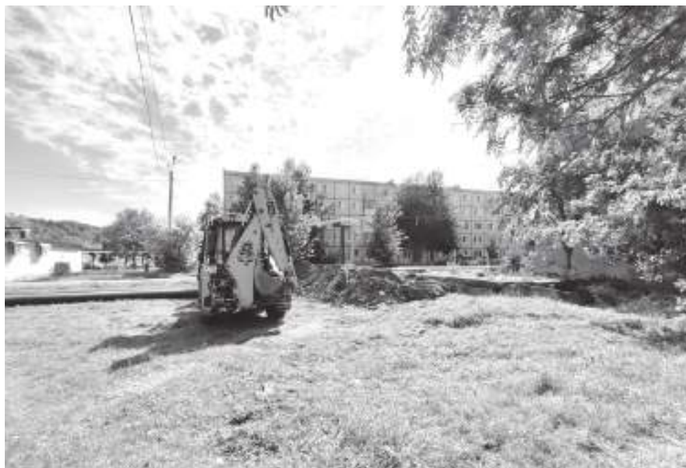
В данный момент подрядчик убирает под землю теплосети от Фабричной, 1 к Фабричной, 4
