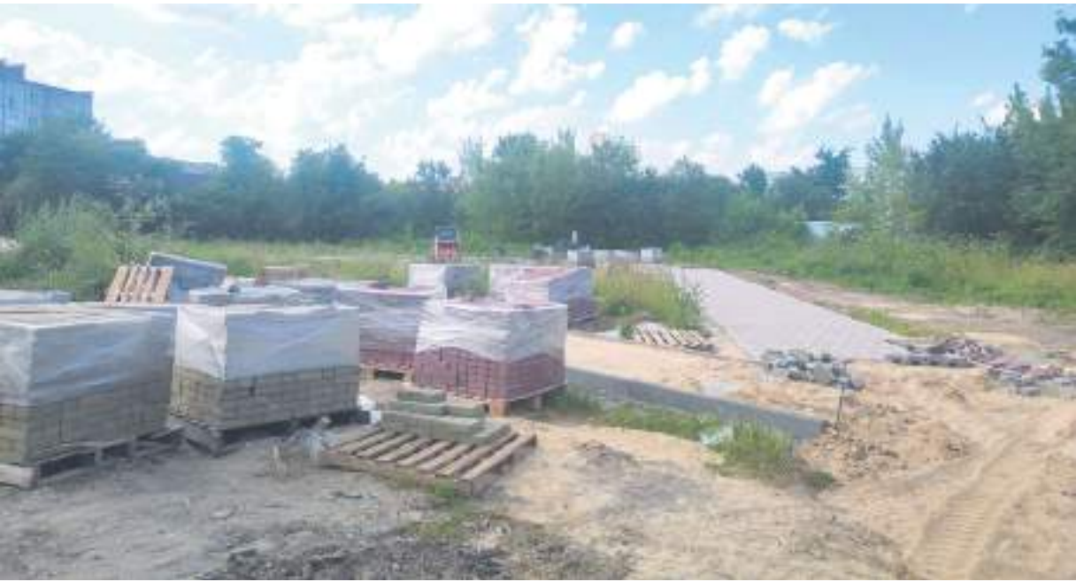
В балабановском «Лесогорье» закипели работы. Однако, скорее всего, подрядчик к сроку уже не успеет
