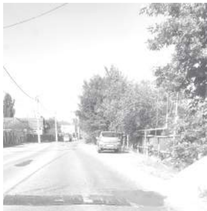
Помимо дорожного покрытия, на Ленина обновят водоотвод и откосы, а также восстановят профиль канав
