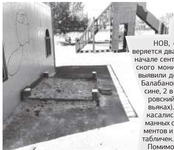
Глядя на это фото, сложно поверить, что «Нарния» – относительно новая площадка Боровска
