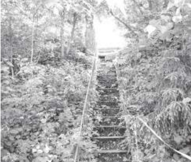
Опасную лестницу в администрации города пообещали демонтировать
