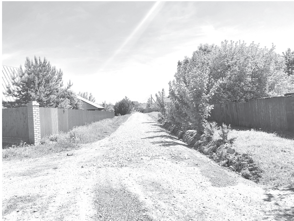
Большой фронт работ по отсыпке щебнем был проделан на улицах по которым «тянули» канализационные трубы
