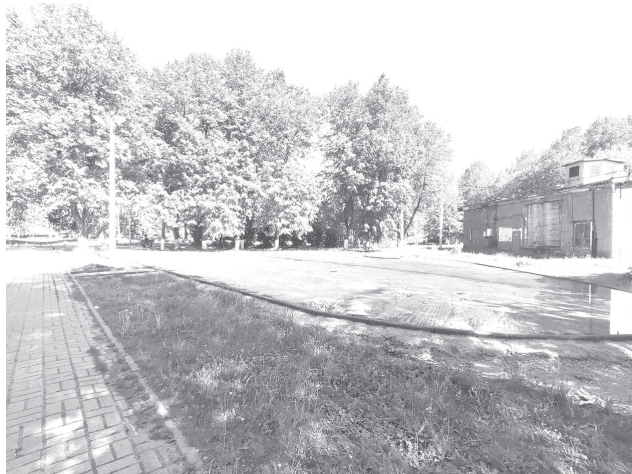
В Ермолине пока готово только бетонное основание под площадку
