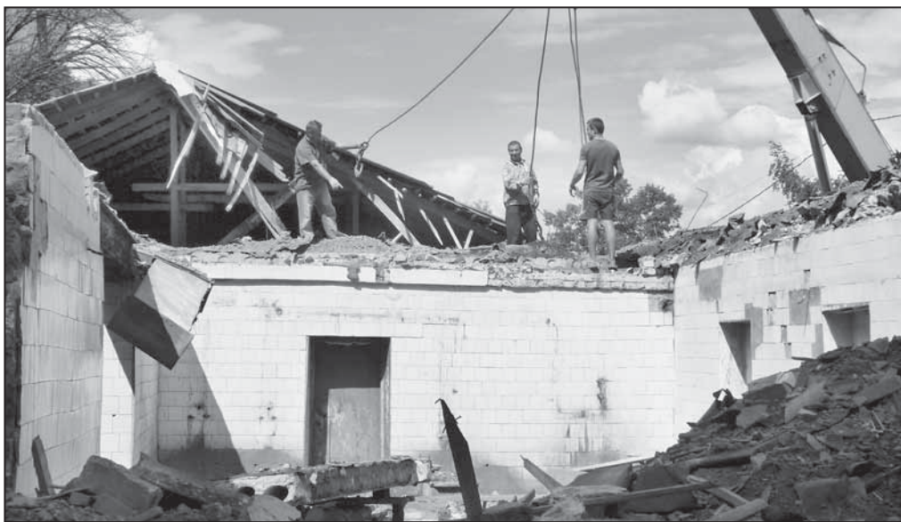
Строители разбирают старое здание бани
