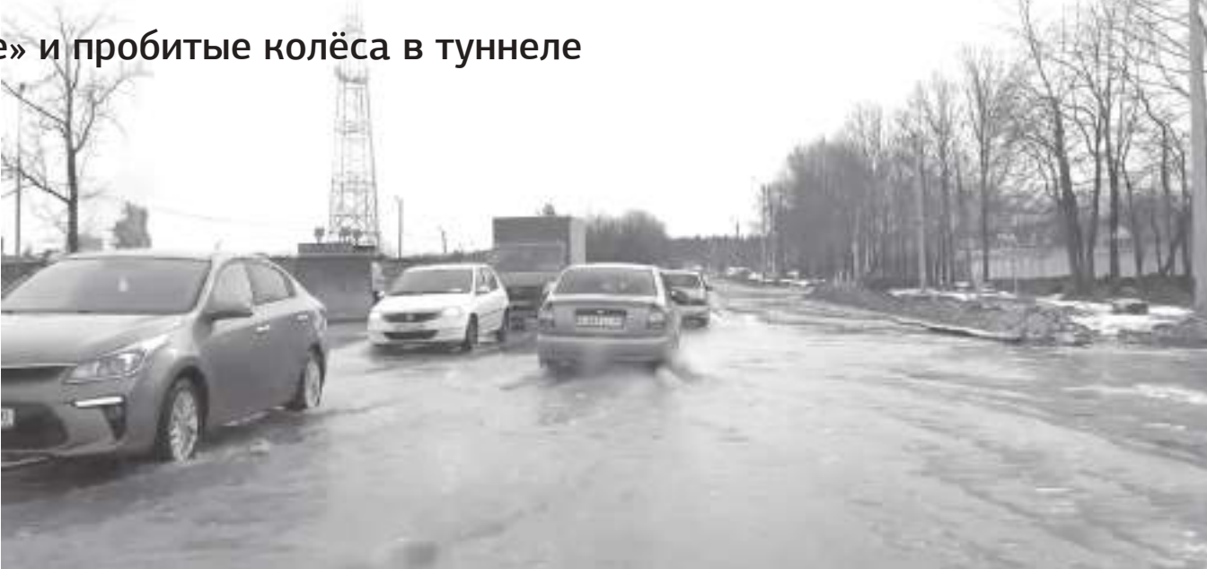
«Тонуть» территория возле туннеля перестанет, похоже, только после строительства дорожной развязки
