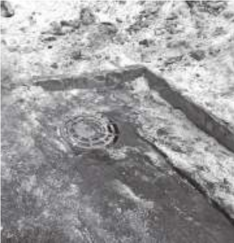
Для того чтобы прочистить ливневую канализацию, коммунальщики сначала убирают сугробы и вывозят снег
