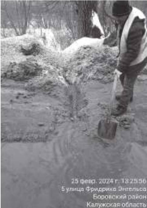
Сотрудники боровского подрядчика «Единство» обеспечивают отток воды с проезжей части на улице Энгельса
