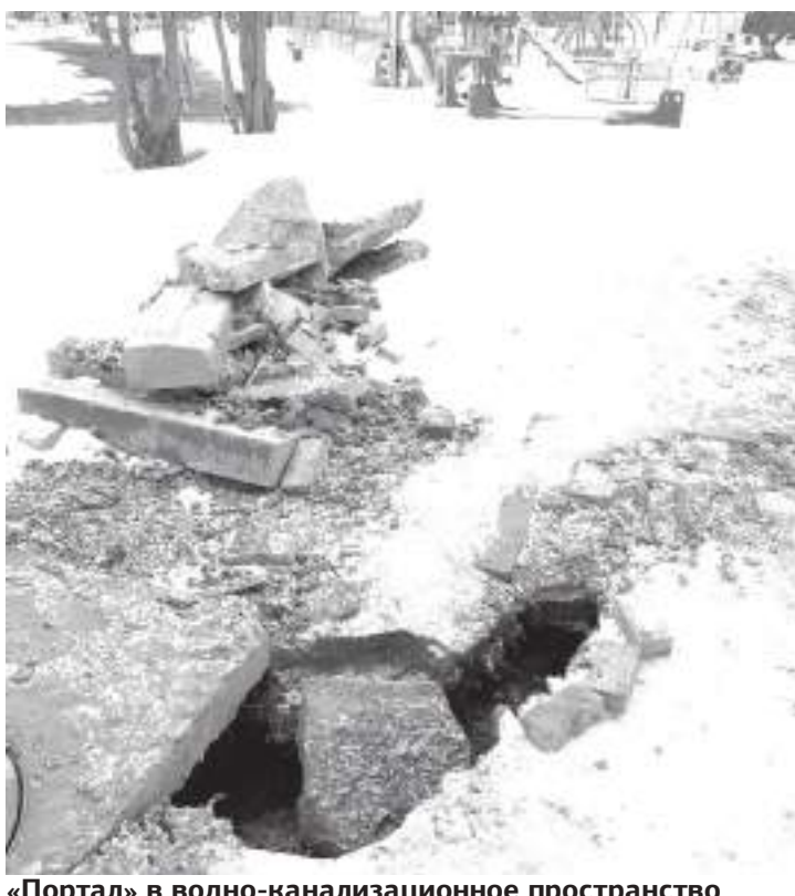
«Портал» в водно-канализационное пространство
