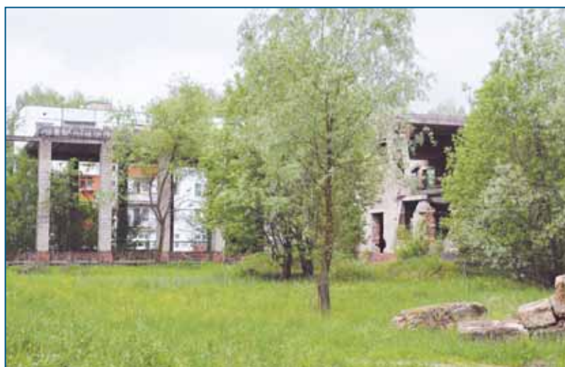
Ломать - не строить. Вскоре стены Дома офицеров совсем исчезнут
