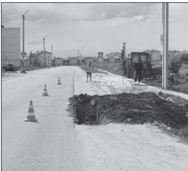
Место будущей остановки в Балабаново
