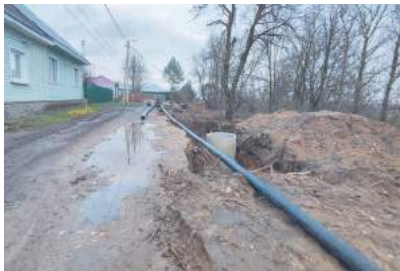
Сейчас трубы монтируют методом прокола под землёй
