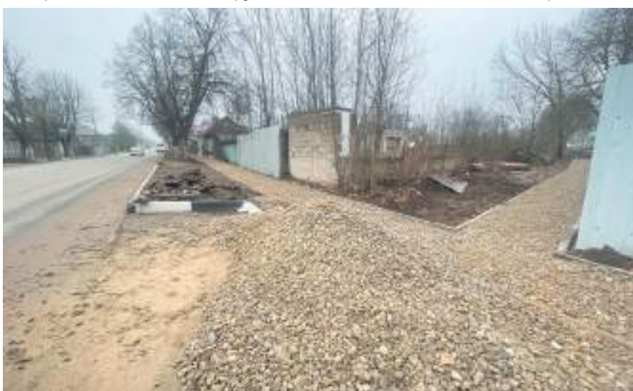
Завершить работы на Калужской подрядчик обещает до конца следующей недели
